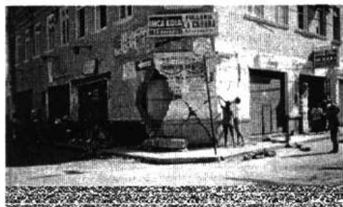
Figura 2. Daño producido en la esquina débil de un edificio en el sismo que sacudió la ciudad de Nazca en noviembre de 1996.
